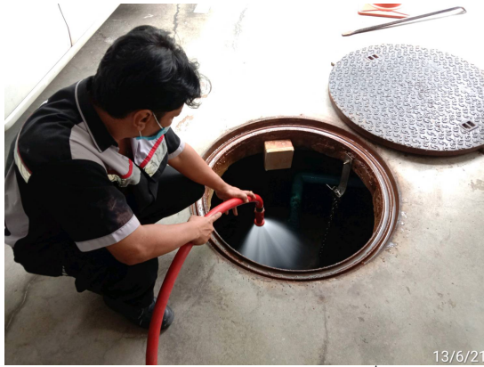
ภาพที่ 3-25 ดูตะกอนล้างบ่อบำบัดน้ำเสีย
