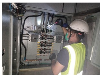
ภาพที่ 3-34 การซ่อมบำรุงระบบไฟฟ้า
