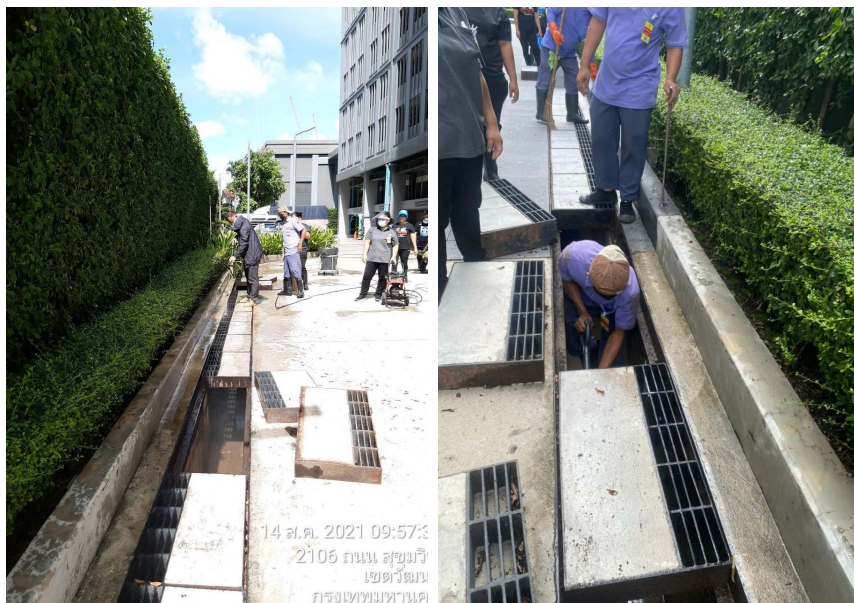
ภาพที่ 3-36 ขุดลอกท่อระบายน้ำและบ่อพักน้ำ
